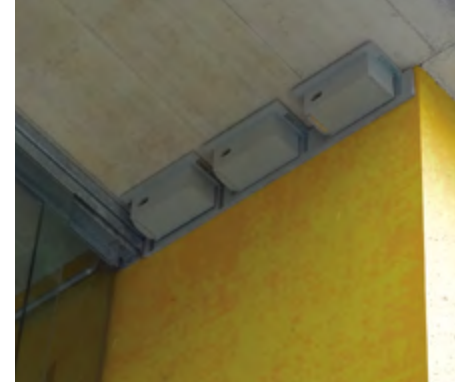
In Eikenøtt entsprechen die Nisthilfen für Segler an die Fassade montierten Holzkästen
